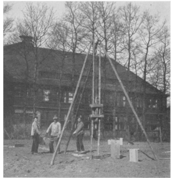
Abb. 2. Das Einrammen der eisernen Behälter für Versuche über Wurzelwachstum unter natürlichen Verhältnissen.
